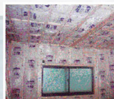
0 断熱材施工の様子
