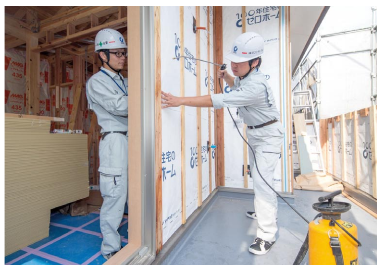
外壁を貼る前に、必ず念入りの水掛け試験を実施。雨漏り軒数を公開するゼロホームの、最重要チェック項目です。
