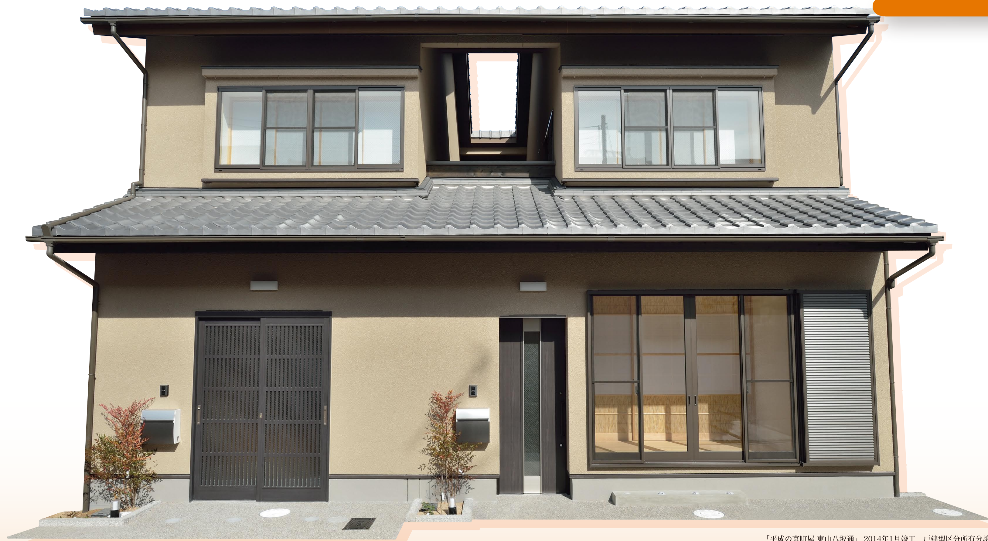
「平成の京町屋 東山八坂通」 2014年1月竣工 戸建型区分所有分譲
