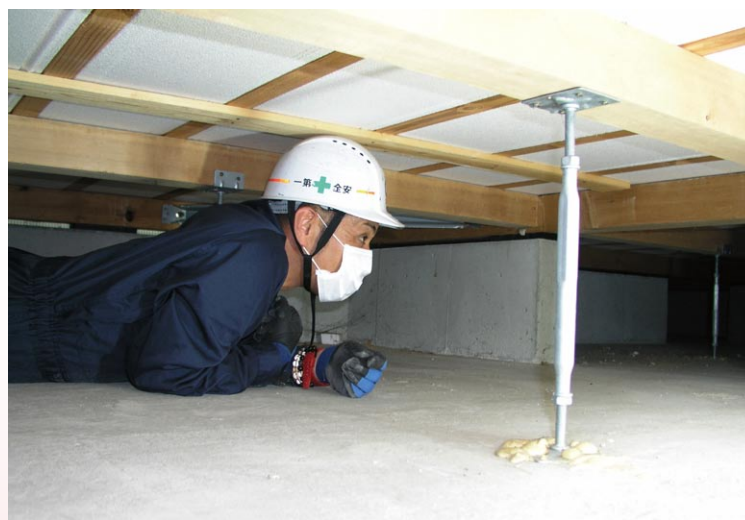
シロアリ、水漏れ、雨漏り跡がないかの確認や、万一の配管トラブルにも対応しやすいよう、ゼロホームの床下は隅々まで行けるようになっています。
