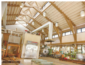
宮崎県 木材利用技術センター
