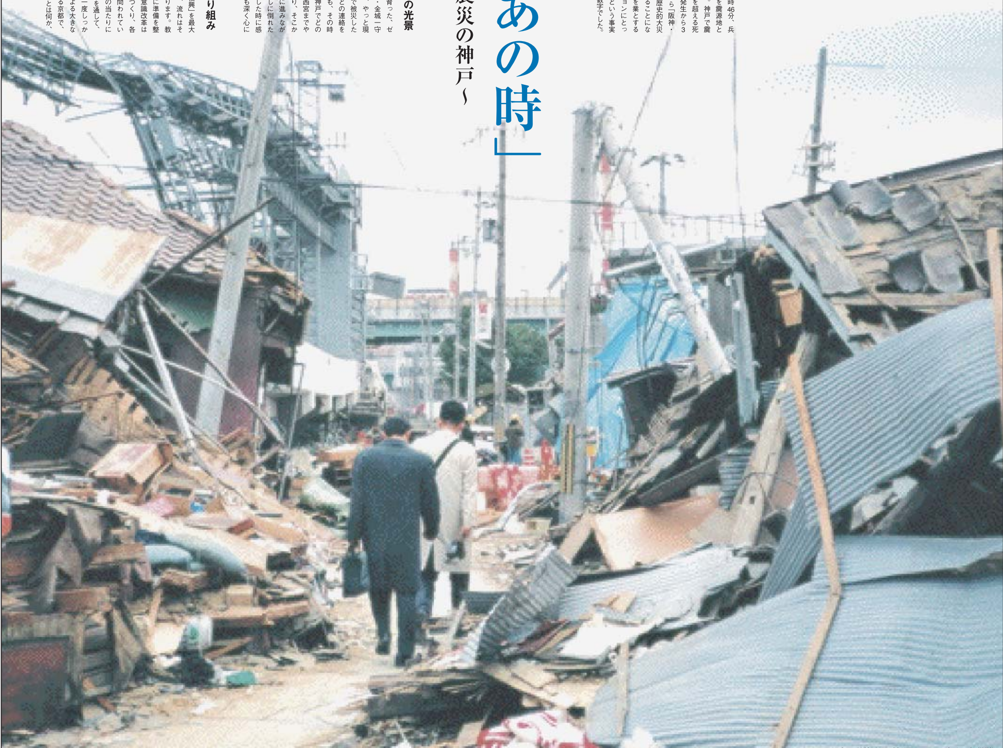
写真:43号線周辺の様子(1995.02.02 金城一守 撮影)
