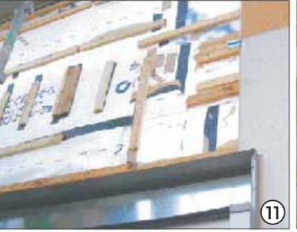
5月15日(火) 問題の横断線を縦断線に変更して水の停滞を防ぐように処置。
