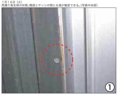
1月16日(火) 雨漏り発生時の状態。鴨居とサッシの間に水滴が確認できる。(写真中央部)
