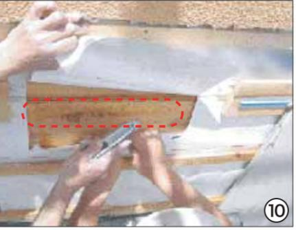
5月15日(火) 浸水箇所のシートをめくり、シート裏に浸水していることを確認。
