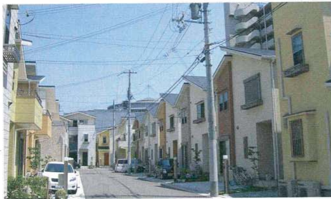
右は、ゼロ・コーポレーションが7月28日付けの京都新聞に掲載した全面広告。漏水トラブルに関する対応は、自社のホームページ( http://www.zero-corp.co.jp/ )でも紹介している。上は、同社の分譲住宅の例 (写真提供：特記以外はゼロ・コーポレーション)
